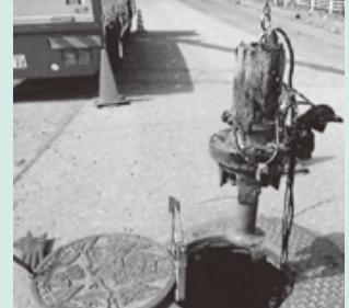
マンホールポンプの 引き上げ作業の様子
